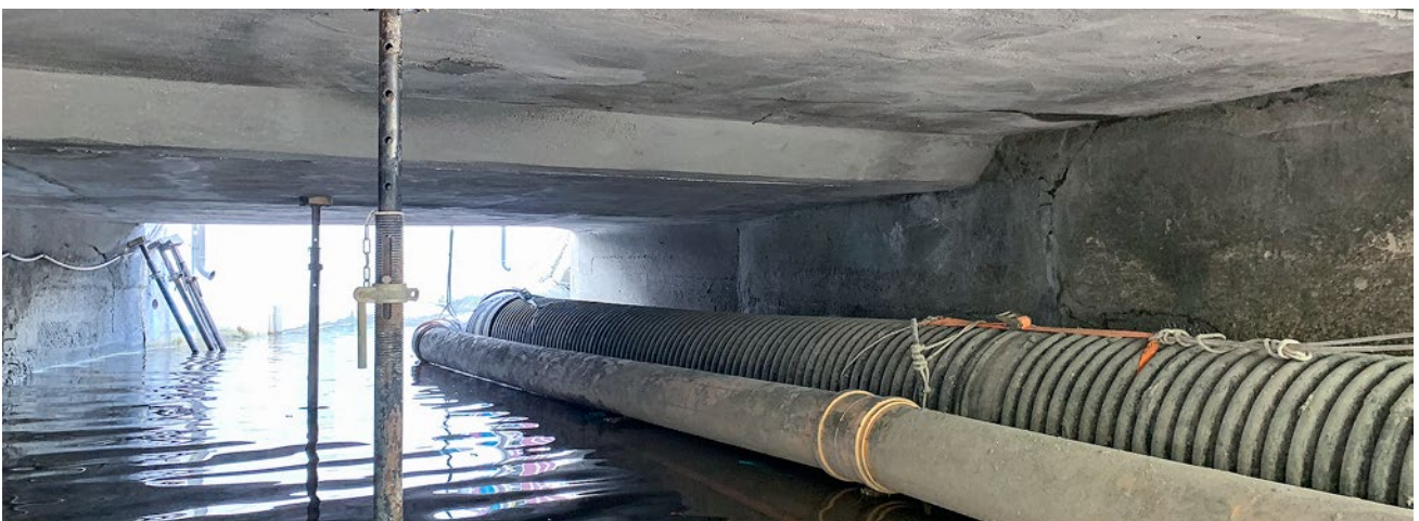
Doorlaatruimte na versterking
