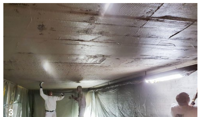
Brandbescherming voor re-plate (A) in combinatie met CFK-Lamellen (B)
