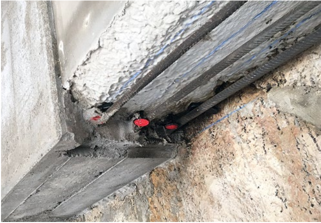
Verankeringszone van drie voorgespannen re-bar 16 met drie beugels Ø12 van constructiestaal in Sika spuitmortel.
