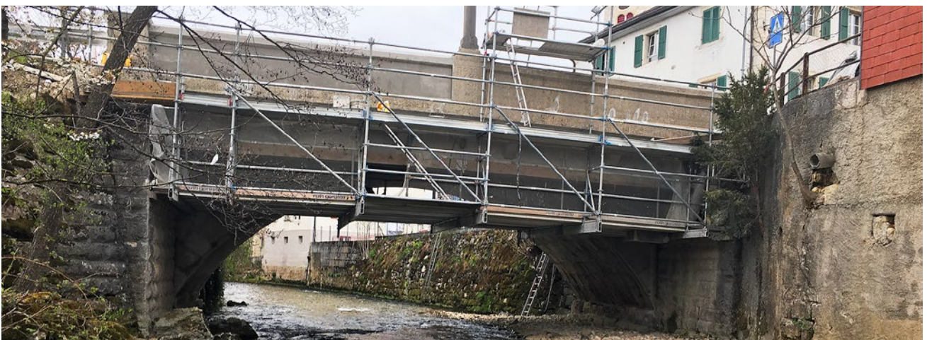
Tijdelijke steigers voor versterking werkzaamheden
