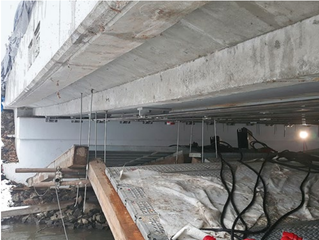
Bestaande stalen liggers met corrosie coating
