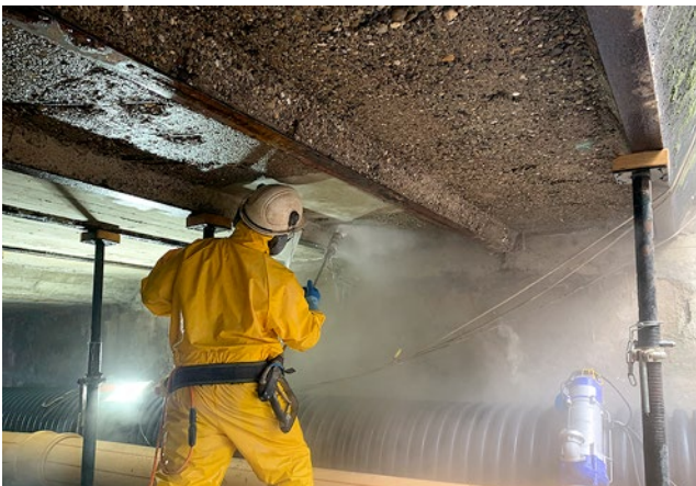
Na verwijderen van de middenwand, provisorisch ondersteunen en hydromechanisch opruwen.
