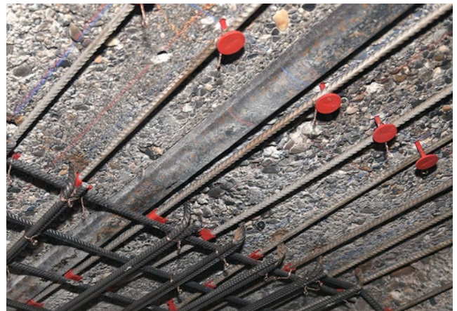
Fixeren van re-bar aan internewapening (re-clip) en aan dragende ondergrond (re-bolt)
