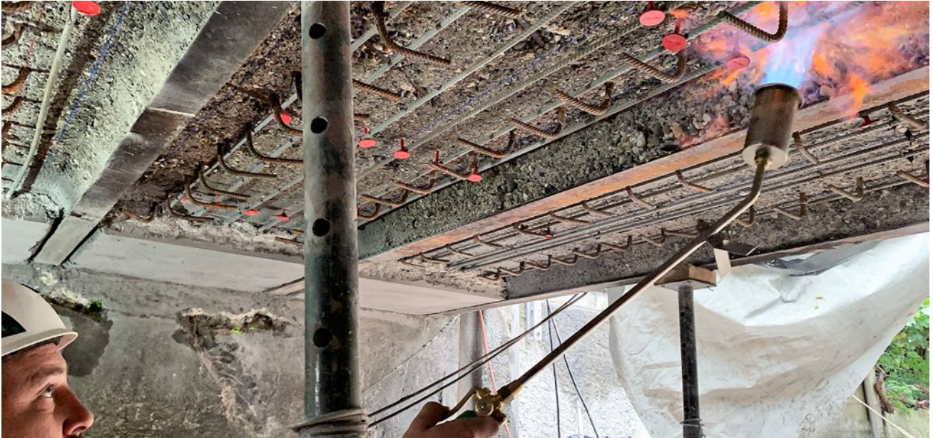
Activering van re-bar met gasvlam en temperatuurcontrole
