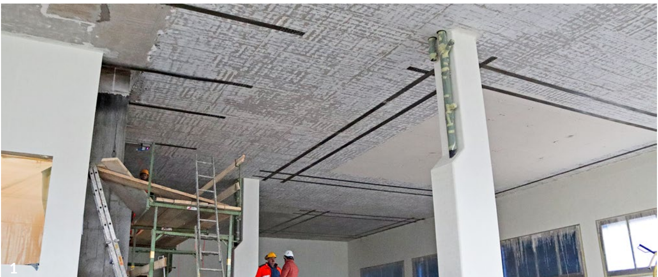
Typische Versterking van het positieve buigmoment met re-plate
